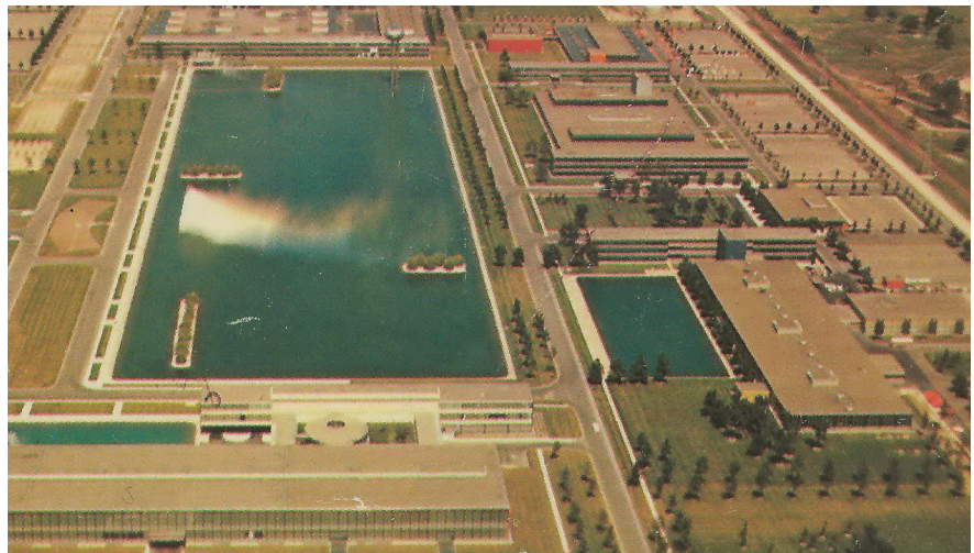
Vue aérienne du Centre Technologique de General Motors conçu par Eero Saarinen. Le campus est destiné à n'être emprunté qu'à 50 km/h, le long de l'autoroute. Image © Donald Harrison/Flickr
