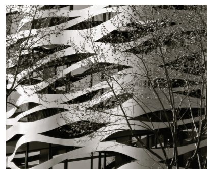
La ristrutturazione della facciata dell’Aparthotel Suites Avenue di Toyo Ito, Barcellona, Spagna, ha una forma biomorfica, esaltando la Luce dinamica e diffusa e le ombre che filtrano nello spazio interno. Immagine © Aslai/ Flickr.
