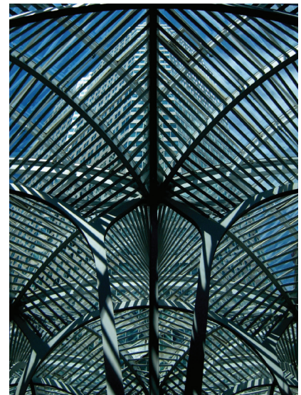
Sopra: l'affascinante struttura del soffitto della Galleria Allen Lambert e dell'Atrium a Brookfield Place di Santiago Calatrava a Toronto. Immagine © Reto Fetz/Flickr.
