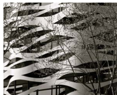
La ristrutturazione della facciata dell’Aparthotel Suites Avenue di Toyo Ito, Barcellona, Spagna, ha una forma biomorfica, esaltando la Luce dinamica e diffusa e le ombre che filtrano nello spazio interno. Immagine © Aslai/ Flickr.
