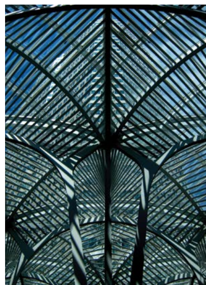
Sopra: l'affascinante struttura del soffitto della Galleria Allen Lambert e dell'Atrium a Brookfield Place di Santiago Calatrava a Toronto. Immagine © Reto Fetz/Flickr.
